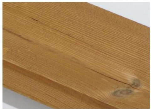
Malé podélné trhliny na povrchu jsou povoleny.
